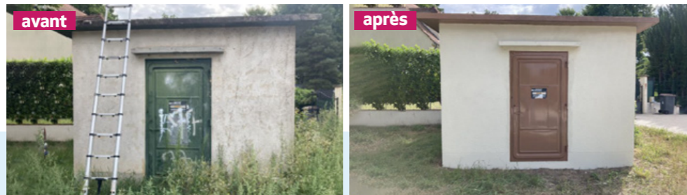
► Poste Mathurin situé à Bourron-Marlotte rénové par DécoPaint 77
