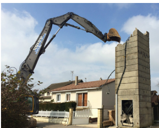
Démolition de poste tour
