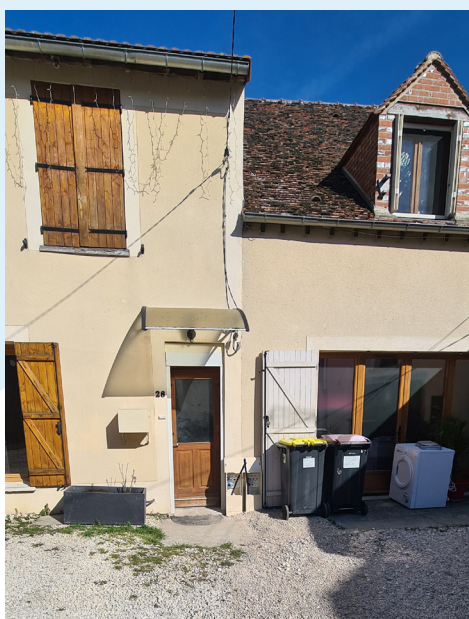
Reprise de branchements dans les cours communes
