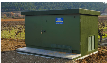
Création de poste de transformation
