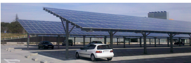
Création d'une ombrière photovoltaïque
